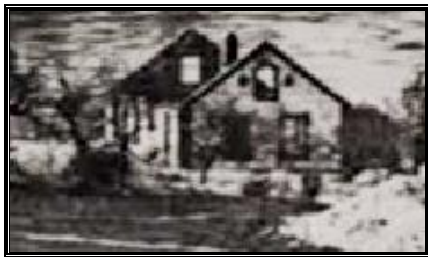
Kalwisch: zerstörtes Haus
